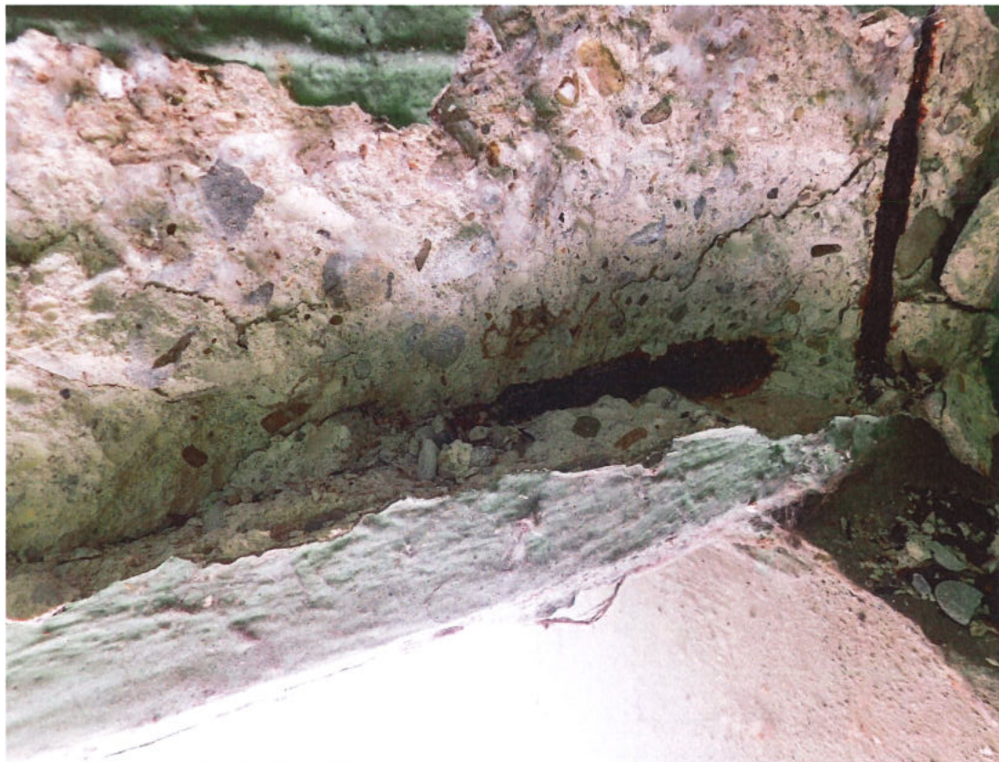
Fot. 6. Odpryski betonu określające występowanie zbrojenia.
