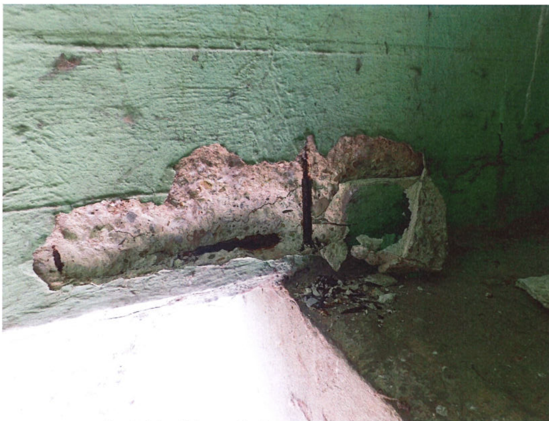
Fot. 5. Odpryski betonu określające występowanie zbrojenia
